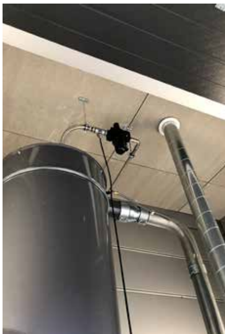
HVU Solo - Alleinstehendes Modul mit Seitenkanalgebläse
